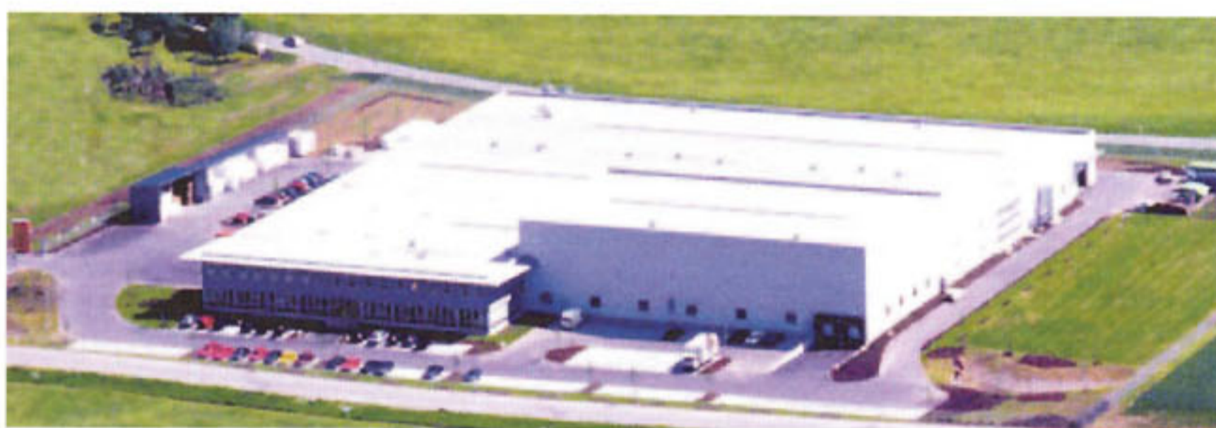
Kana eröffnete in Wangen im Allgäu einen Standort, um von dort aus eine noch optimalere Betreuung der Bau- und Heimwerkermärkte zu gewährleisten.
